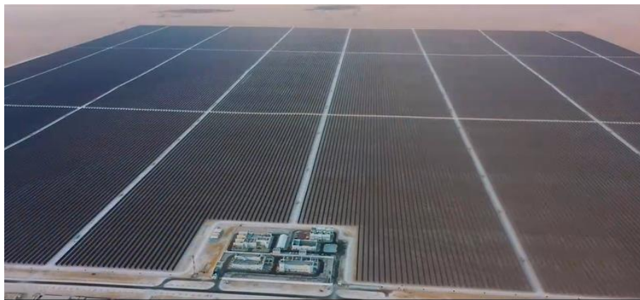
Al Kharsaah PV plant, 800MW, Qatar
